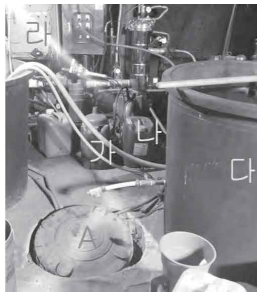
안동의 B농가는 각종 자재를 직접 만들어 사용하고 있다. 가. 동물성아미노산 액비 나. 액비(보카시 발효액비) 다. 액비혼합물 라. 관수라인을 타이머를 이용하여 자동화했다 : 물량을 정확하게 줄 수 있게 됨. A. 5톤 액비발효통과 5톤 물통을 하우스 작업장 지하에 매설했다 : 수온이 너무 오르거나 떨어지지 않으면서 작업장 공간활용이 높아진다.
