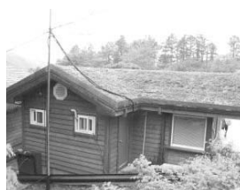
지리산국립공원관리사무소 지붕녹화 사례.
